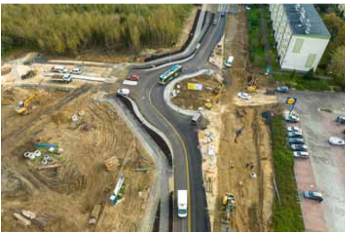
Na ulicy Szujskiego powoli kończy się budowa ronda turbinowego z dwoma pasami ruchu oraz drogami dla pieszych i rowerzystów.
