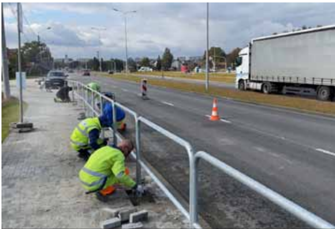
Dobiega końca układanie nowych nawierzchni chodników na zmodernizowanej części ul. Lwowskiej.
