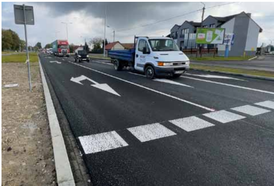
Na znacznej części ul. Lwowskiej jeździmy już po nowej nawierzchni
