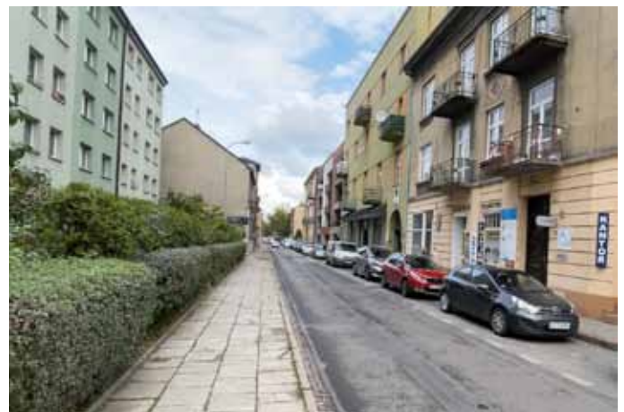
Nowa nawierzchnia jezdni i nowe chodniki pojawią się na całej długości ul. Krasińskiego
