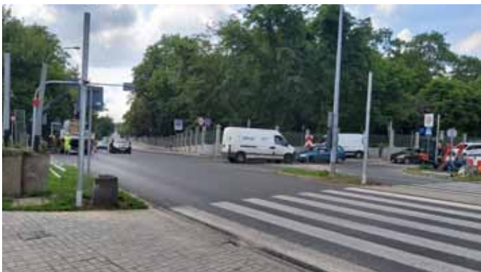
Prace przy montażu nowej sygnalizacji świetlnej, która uzupełniona została o system kamer monitorujących i nadzorujących ruch
