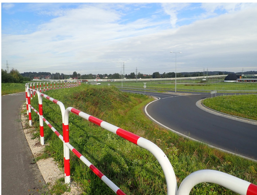
Widok w kierunku zachodnim
