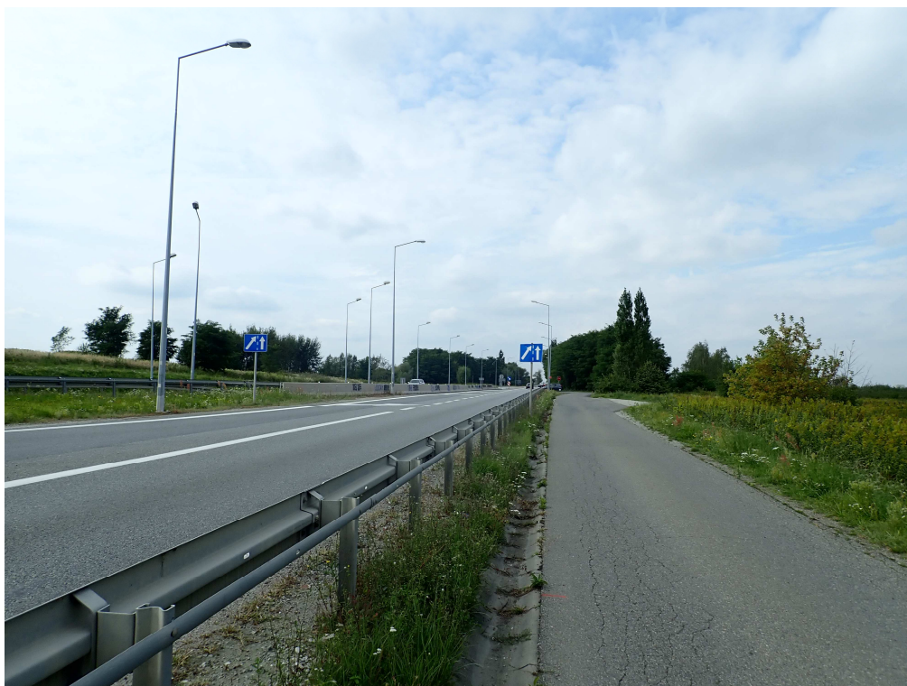
Widok w kierunku zachodnim
