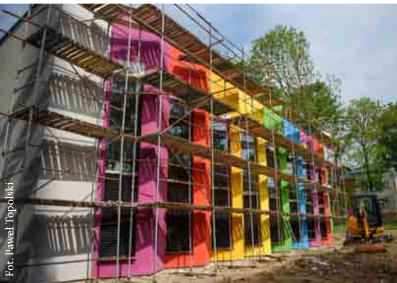
Budowa sali sportowej przy Zespole Szkół Ogólnokształcących nr 2.
