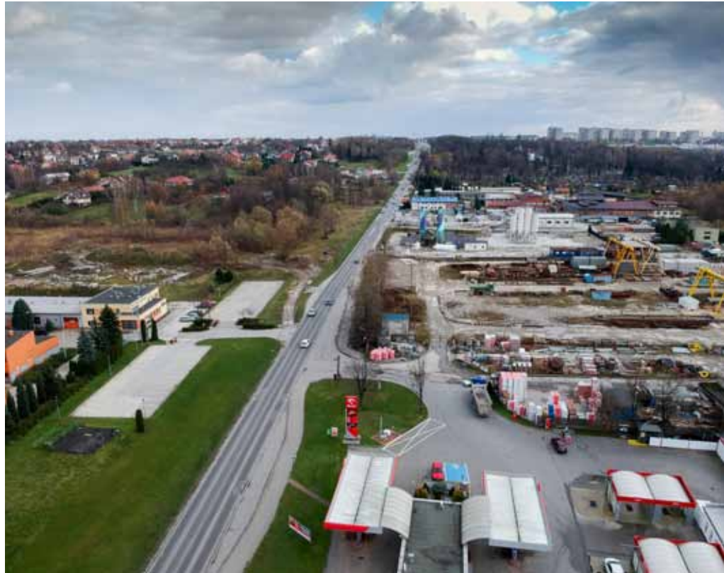
Ulica Spokojna pod modernizacji będzie mieć po dwa pasy w jednym kierunku.
