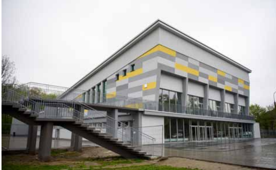
Hala przy ul. Gumniskiej po termomodernizacji.
