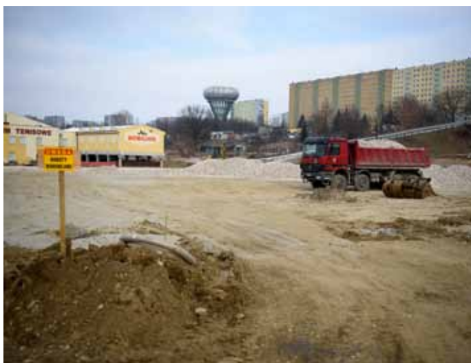
Trwają prace przy budowie boiska przy ulicy Wojska Polskiego.
