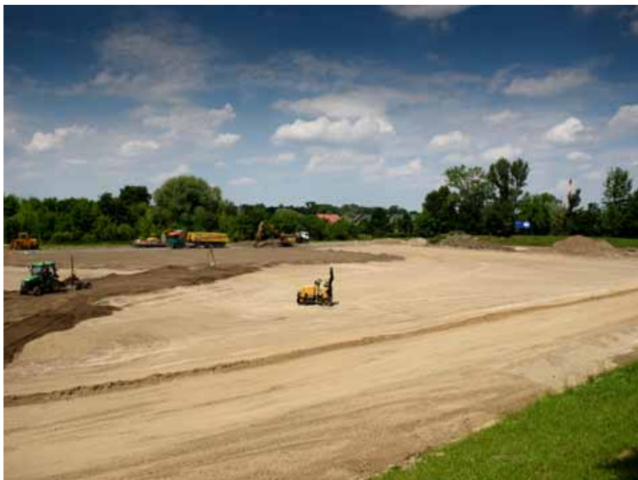
Stadion na „Błękitnych” w trakcie prac. Teren został zdrenowany. Wykonawca rozpoczął układanie nawierzchni trawiastej boiska piłkarskiego.
