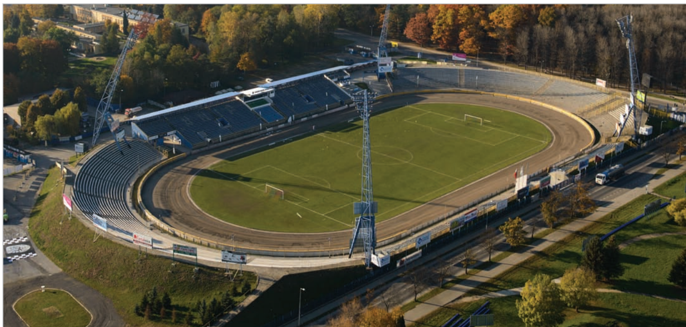
W tym roku postawiony zostanie pierwszy krok w kierunku przebudowy Stadionu Miejskiego.
